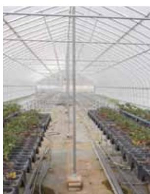
写真3 中柱の設置
